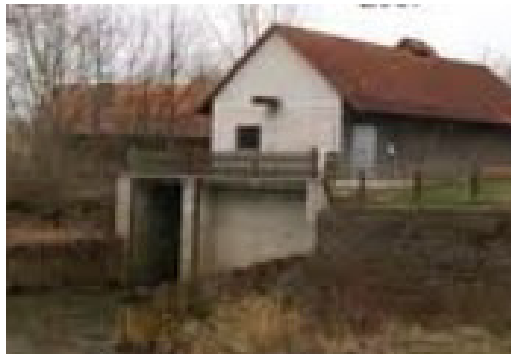
Kaplanturbine Okermündung 0,3 MW, Bj. 89
