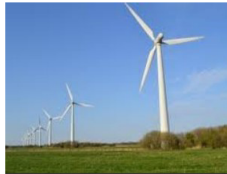
Windpark „Padingbüttel“ 5 MW, Bj. 93
