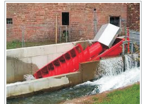
Baugenehmigung Wasser- schnecke, 130 kW, 2014
